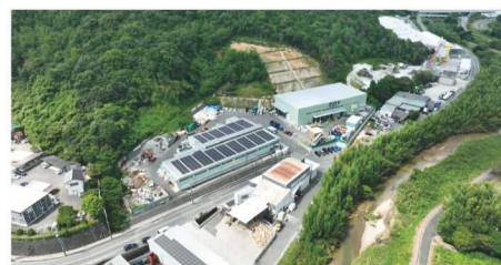
太陽光発電システムを設置したMDSリソースセンター
